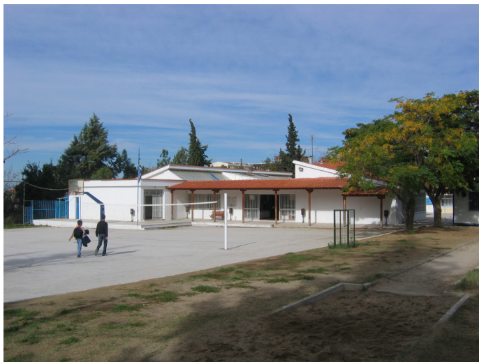
Φωτο 3: Προσωρινή στέγαση στο κτίριο του 3 ου Δημοτικού Σχολείου Πεύκων
