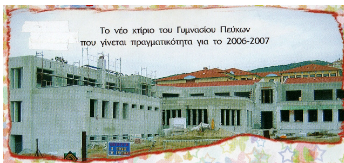
Φωτο 4: Κατασκευή του διδακτηρίου του Γυμνασίου Πεύκων
